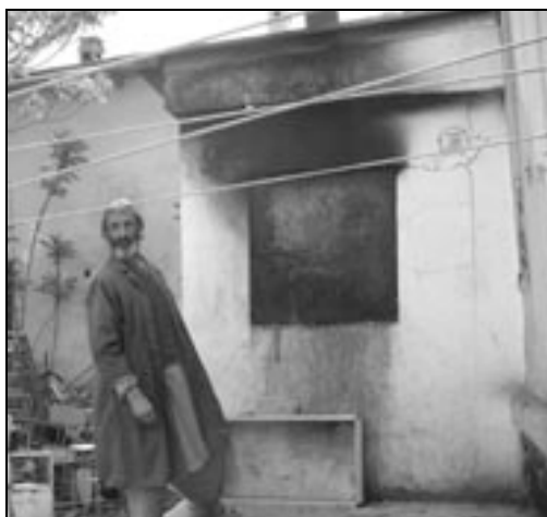
Incinérateur de l'Hôpital de Ali Abad
